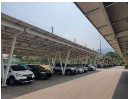
รูปที่ 4.2 ภาพตัวอย่างแสดงโรงจอดรถติดตั้งระบบผลิตไฟฟ้าด้วยแสงอาทิตย์
